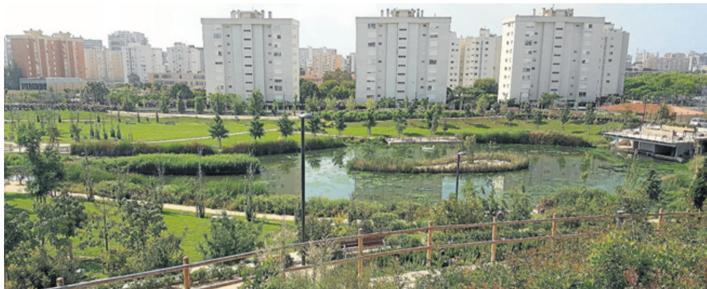
El parque inundable la Marjal es una obra de marcado carácter social que da solución a los problemas de inundaciones en la zona.
