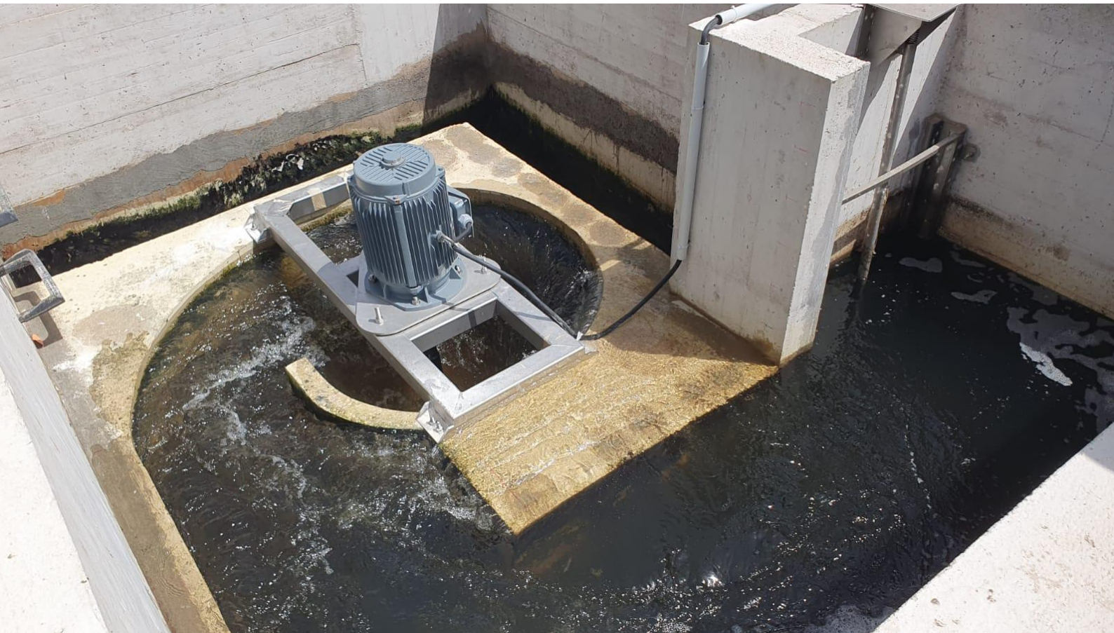
Picoturbina de generación eléctrica en la EDAR Monte Orgegia
