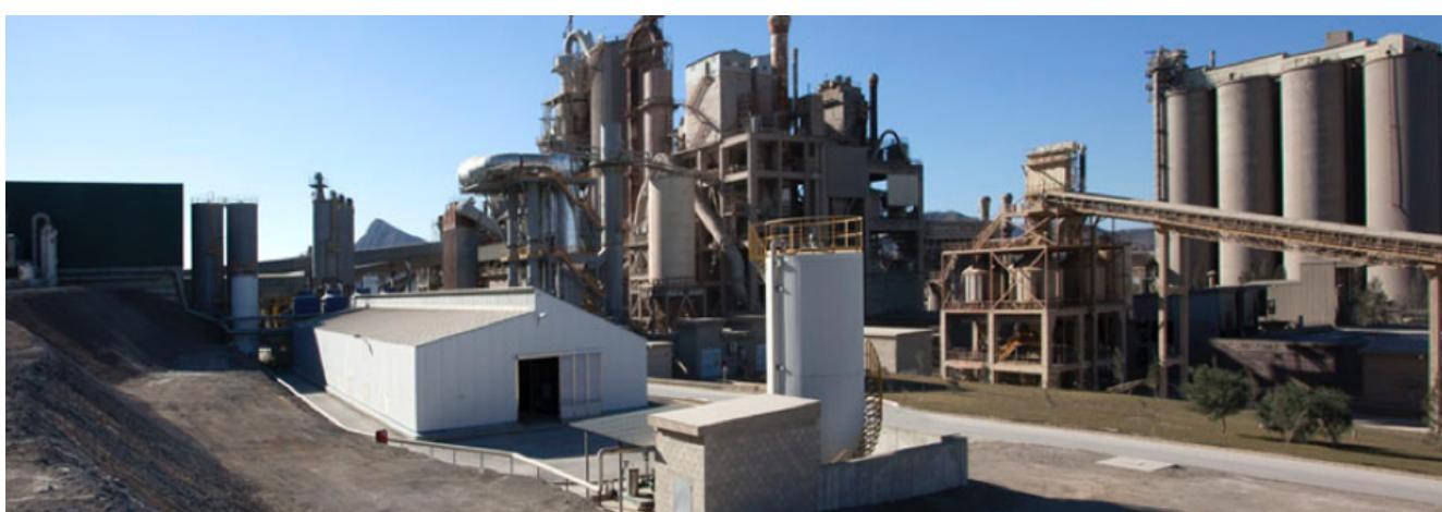
La planta de secado térmico de lodos se localiza dentro del recinto de la fábrica de cemento de Cemex en Alicante. Existen dos líneas de tratamiento en paralelo mediante un sistema de secado que se basa en hacer circular aire caliente dentro del lodo, de manera que se evapore el agua contenida, la cual es condensada posteriormente.
