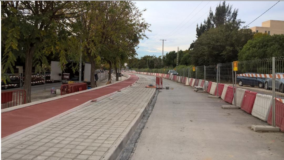
Foto 18: Nuevo carril bici sobre colector Ø1000.
