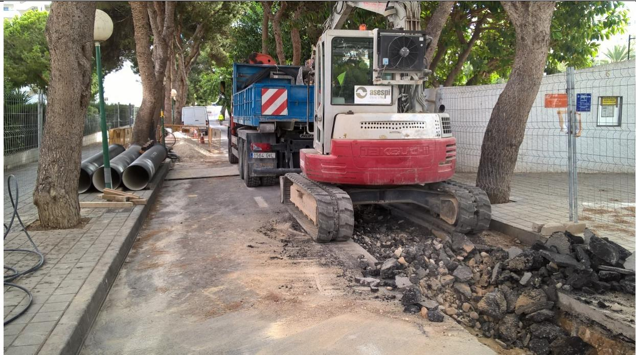
Foto 12: Canalización agua potable Ø500 C/ Melva.
