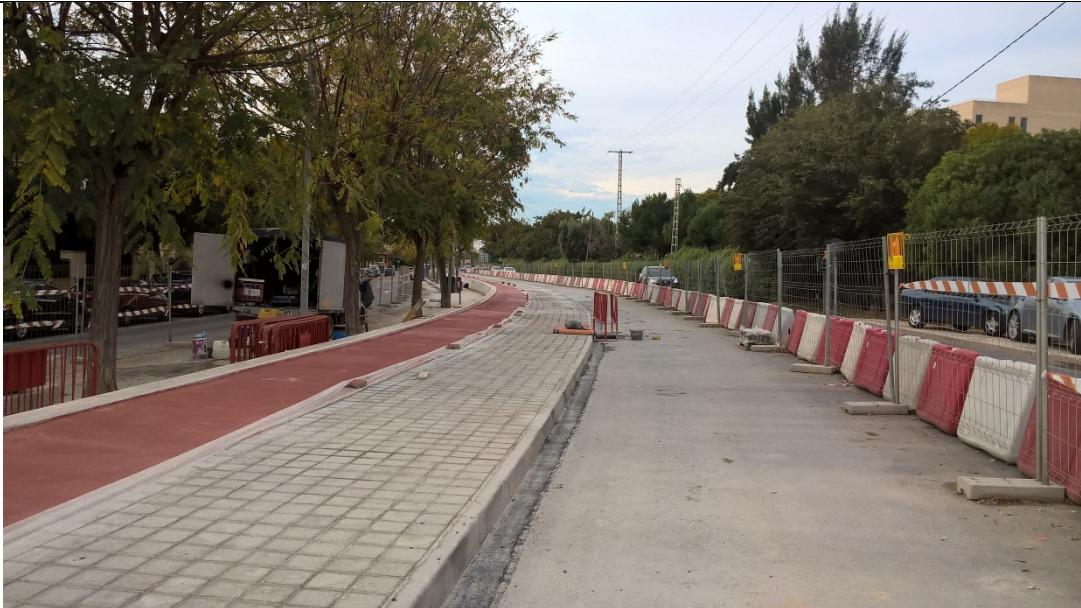
Foto 18: Nuevo carril bici sobre colector Ø1000.
