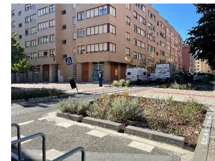
Figura 41. Parterre inundable (área de biorretención) en C/ Carmen Baroja, Pamplona.
