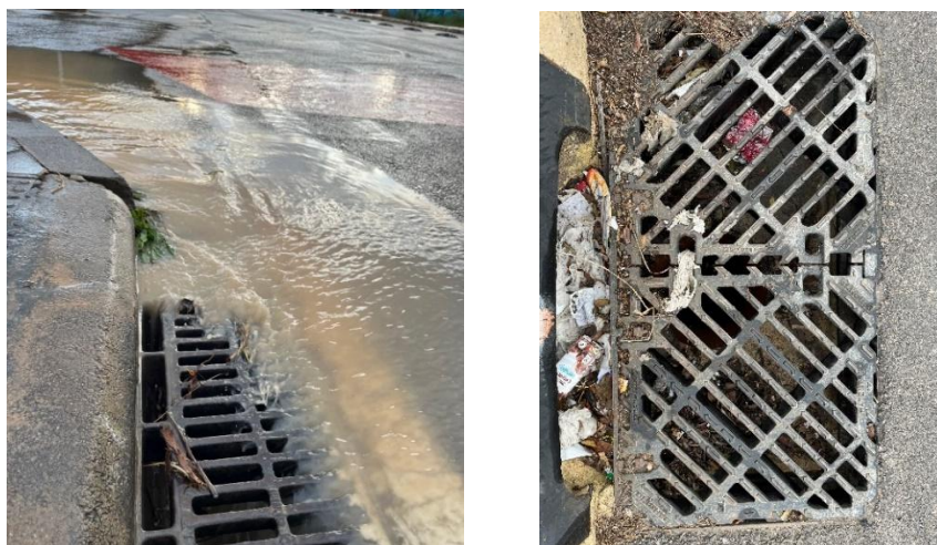
Figura 5. Arrastre de sedimentos y contaminantes por la escorrentía durante un evento de lluvia.
