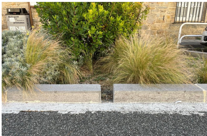
Figura 10. Bordillo intermitente. Entrada hacia área de biorretención en Pamplona (España).
