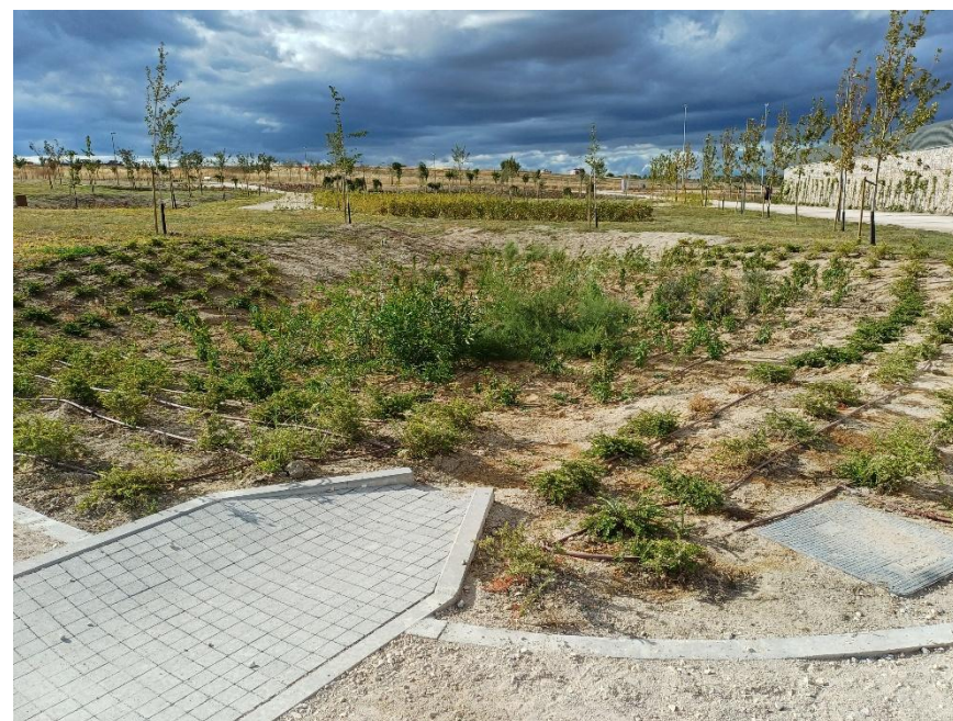
Figura 11. Elementos de rebose superficial interconectando SUDS en el Parque Ferial de Fuenlabrada.
