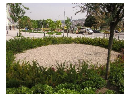
Figura 42. Balsa de detención e infiltración en Can Cortada, Barcelona.
