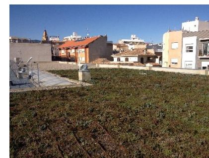
Figura 40. Cubierta vegetada en el Centro de Multiusos, Benaguasil.
