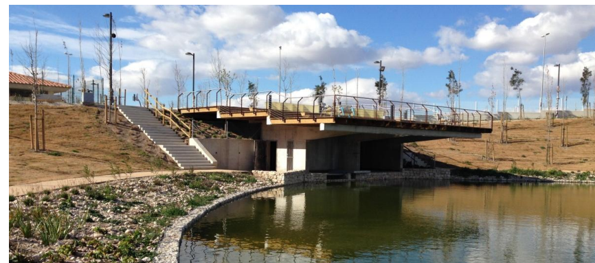
Figura 34. Mirador sobre el estanque del parque La Marjal, Alicante. Fuente: Aguas de Alicante.
