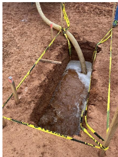
2° Llenado de la zanja.
