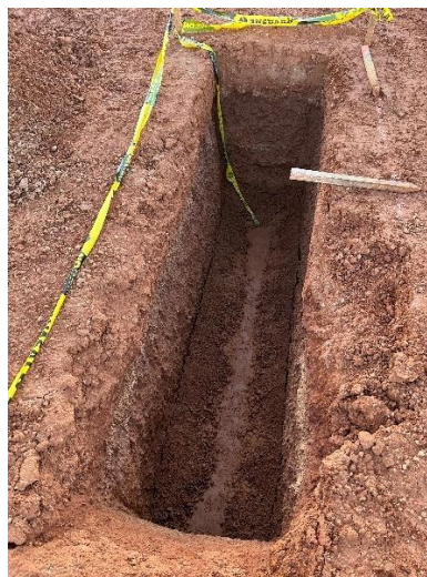
4° Vaciado completo de la zanja y nuevo llenado hasta completar 3 ensayos.
