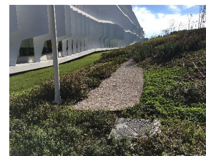
Figura 46. Dren filtrante en la nueva sede del BBVA, Madrid.
