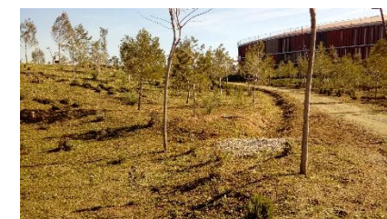
Figura 43. Cuneta vegetada en Anillo Mediterráneo, Tarragona.
