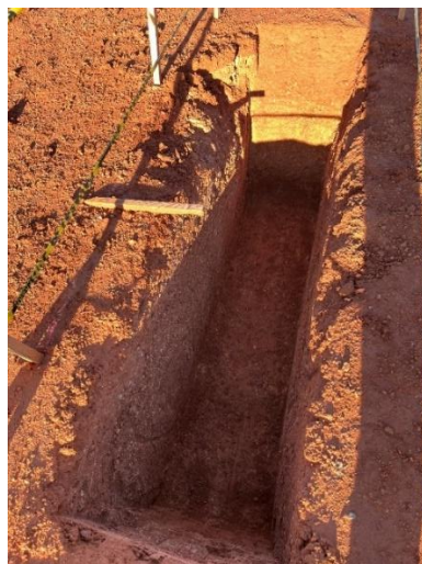
1° Excavación de una zanja prismática de dimensiones conocidas.
